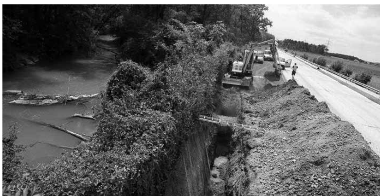
Fig. 13 Riparazione dell'argine lungo l'autostrada Lyss-Bienne in Svizzera. Tratto da http://www.cscf.ch
