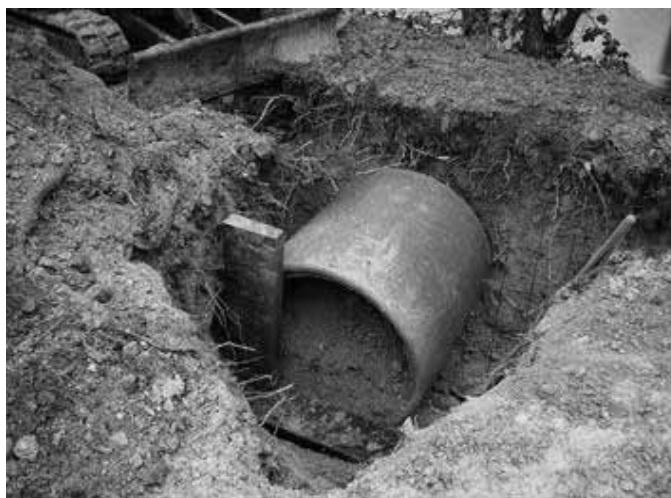
Fig. 14 Installazione di una tana artificiale.
